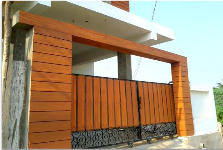
Gate Cladding - (V-Plank)
